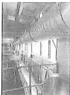
Fig. 6 - Interno dell'impianto a fine lavori.
