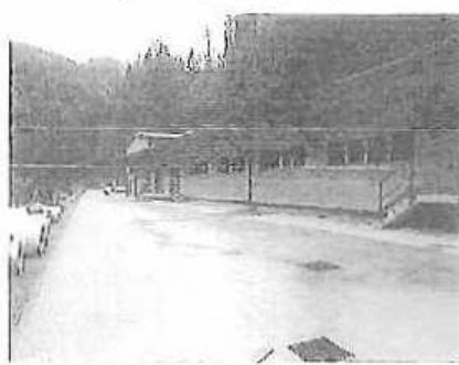
Fig. 7 - Esterno dell'impianto a fine lavori.
