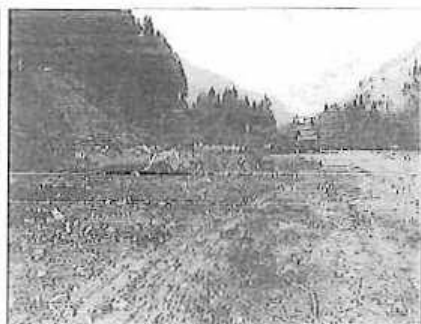
Fig. 4 - Il sito in località Dezzo a inizio lavori.
