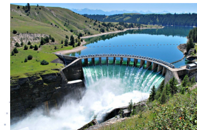
Energia idraulica (meno programmabile che in passato?)
